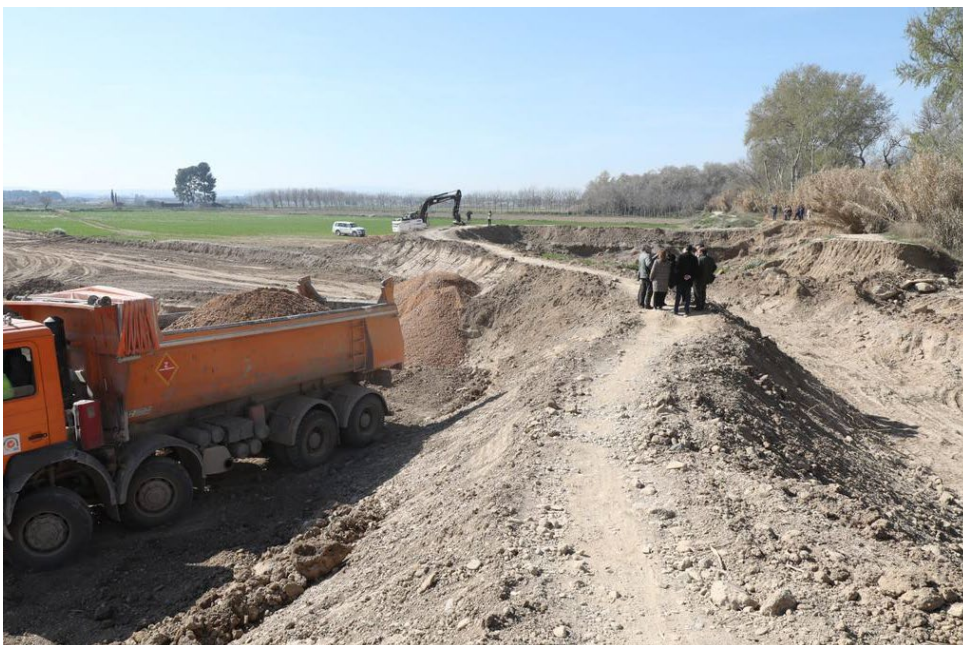
Trabajos de consolidación de la mota de protección en el río Ebro. Fuente: El Periódico de Aragón.
