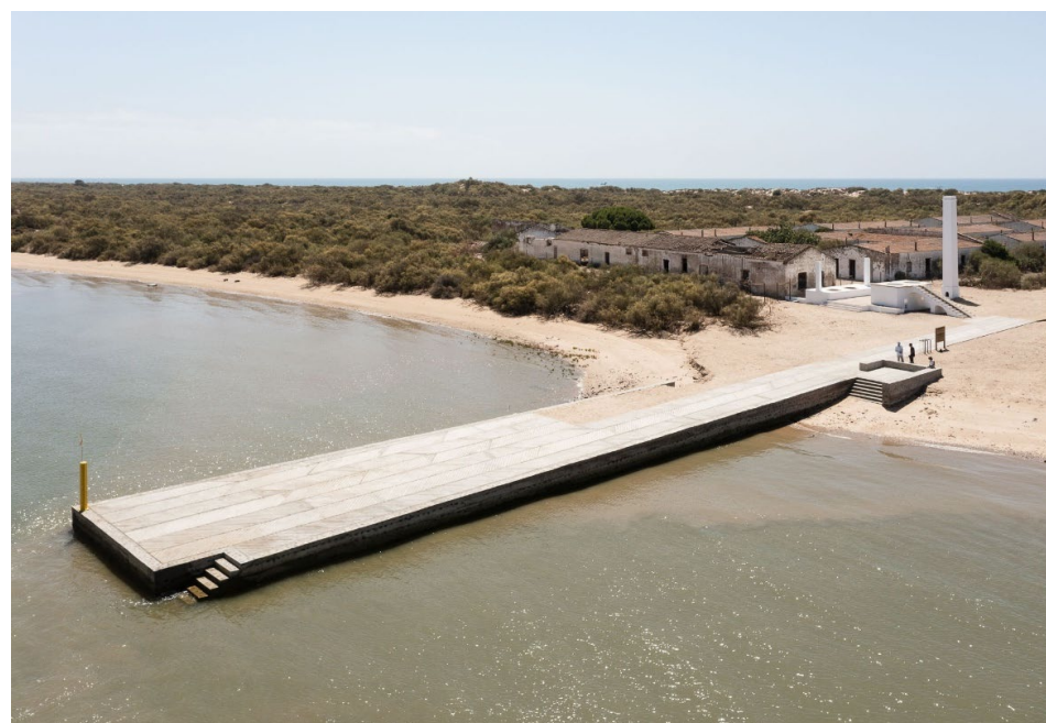
Espigón en la Alameda del Rompido, España. Fuente: Sol89 Arquitectos.
