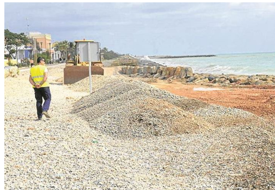
Relleno con gravas en Almenara, España. Fuente: Dirección General de Costas, Gobierno de España.
