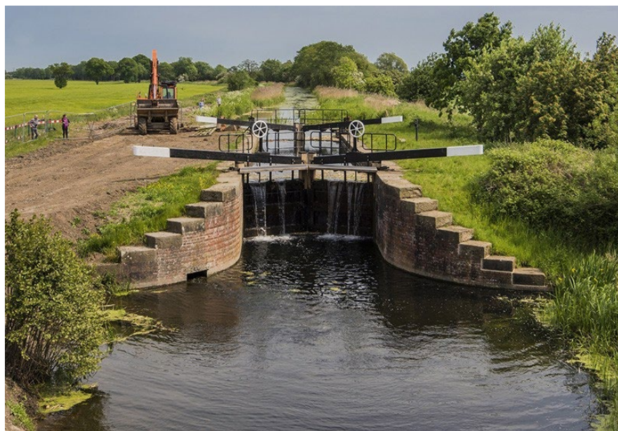
Compuertas en Bekhamste, UK. Fuente: River Trust.org
