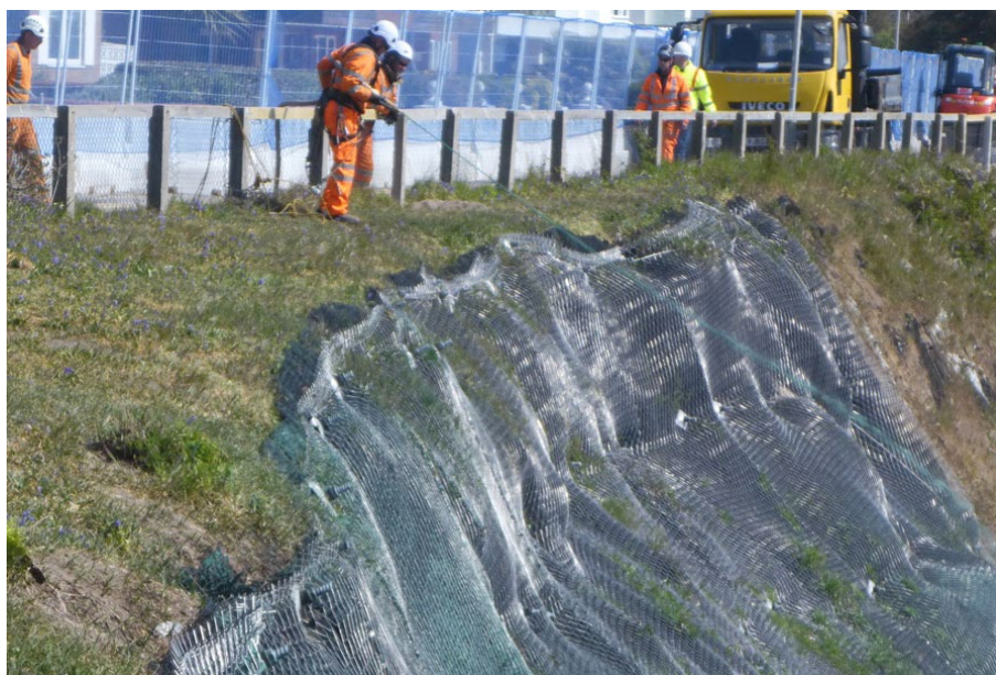
Tareas de estabilización en los Acantilados de Canford, Reino Unido . Fuente: BCP Council.
