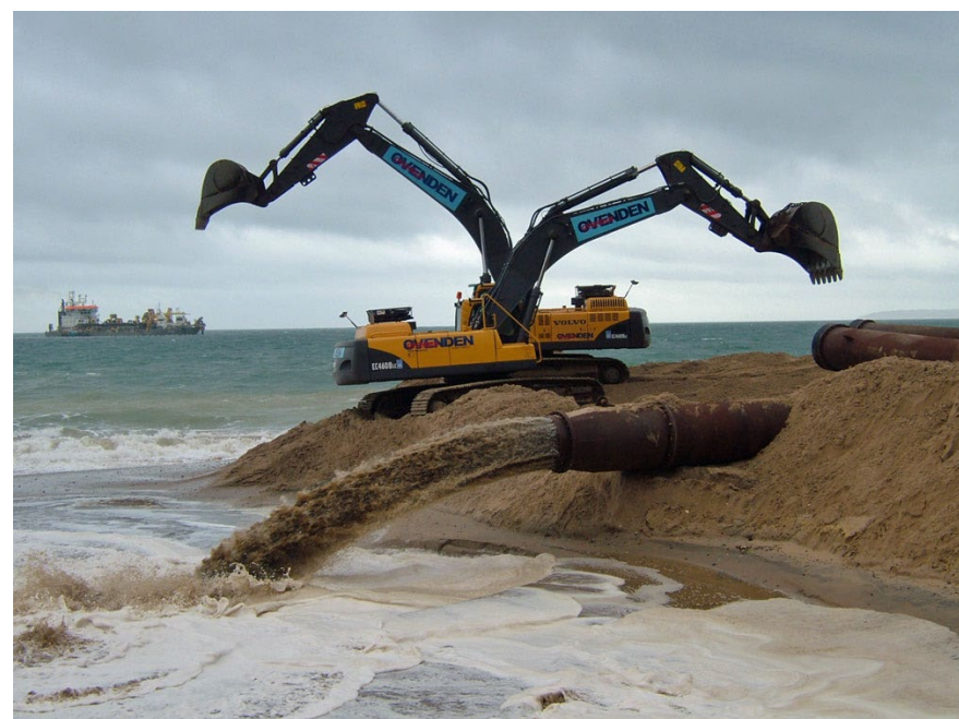
Trabajos de regeneración de playas en la Bahía de Poole, Reino Unido. Fuente: BCP Council.
