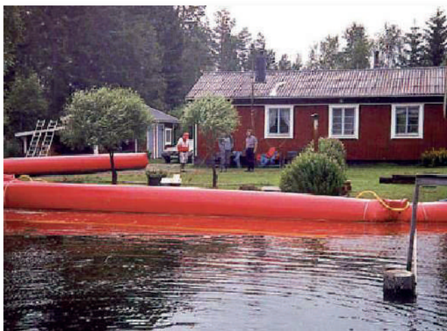
Figura 43. Izq.: barreras anti-inundación temporal de contención móvil con sellado hermético. Fuente: Tandem. Dcha.: barras de protección modular anti-inundación de instalación temporal, con placas de anclaje y perfiles preinstalados hormigonados. Fuente: CAG Canalizaciones.
