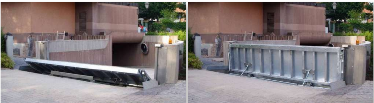
Figura 41. Compuerta abatible neumática, oculta bajo tierra y levantada automáticamente por presión en caso de inundación. Fuente: Aggères.
