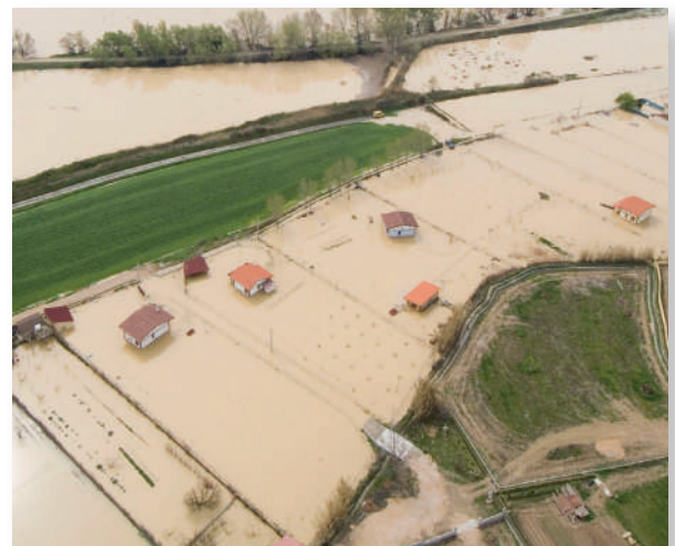
Figura 30. Viviendas rodeadas de agua durante las inundaciones de 2007, Falces (Navarra). Fuente: Gobierno de Navarra.
