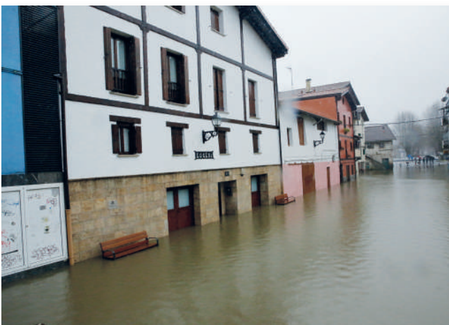
Figura 12. Inundación registrada en Astigarraga (Gipuzkoa). Fuente: CCS.
