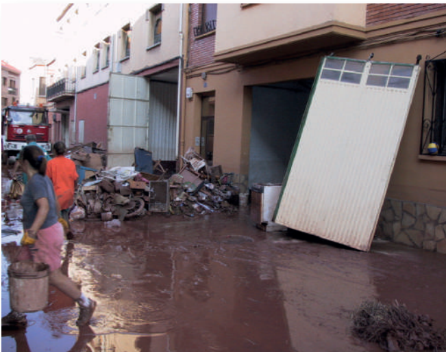
Figura 11. Daños en edificaciones debidas a las inundaciones en Huércanos (La Rioja). Fuente: SOS Rioja.
