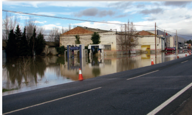
Figura 8. Arriba: edificación construida invadiendo el encauzamiento, Alginet (Valencia). Fuente: Inclam. Abajo: drenaje insuficiente en la carretera NA-115, Peralta (Navarra). Fuente: Gobierno de Navarra.
