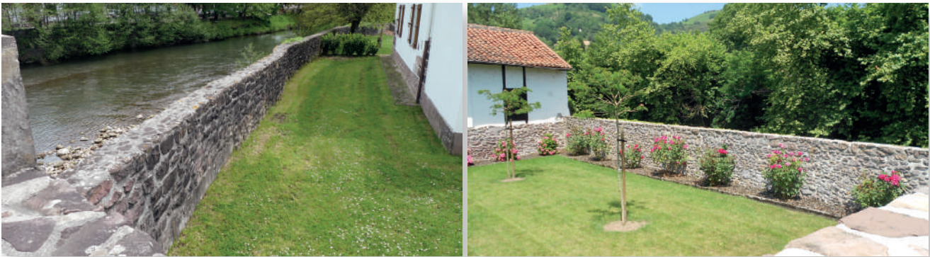
Figura 39. Muros perimetrales de protección frente a inundaciones. Elizondo (Navarra). Fuente: Gobierno de Navarra.
