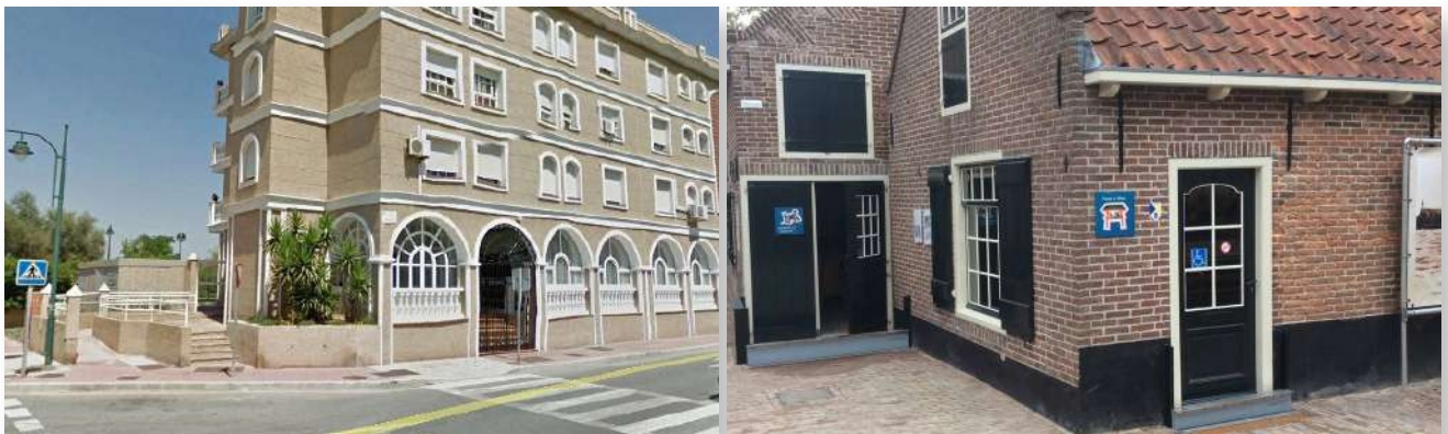
Figura 47. Izq.: edificio de viviendas adaptado a las inundaciones, en el que se han elevado los umbrales de puertas y ventanas a través de los cuales podría penetrar el agua. Guadalmar (Málaga). Fuente: Google Street View. Dcha.: edificio protegido con barras de protección anti-inundación con autocierre por presión de agua. Fuentes: Aggérés.
