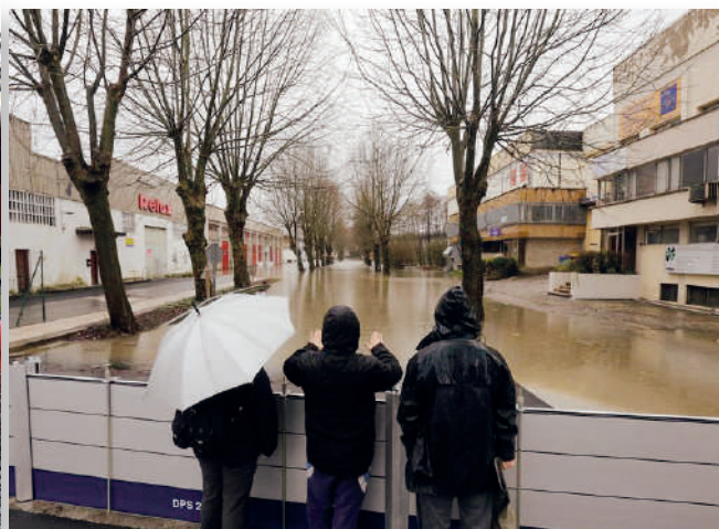
Figura 43. Izq.: barreras anti-inundación temporal de contención móvil con sellado hermético. Fuente: Tandem. Dcha.: barras de protección modular anti-inundación de instalación temporal, con placas de anclaje y perfiles preinstalados hormigonados. Fuente: CAG Canalizaciones.
