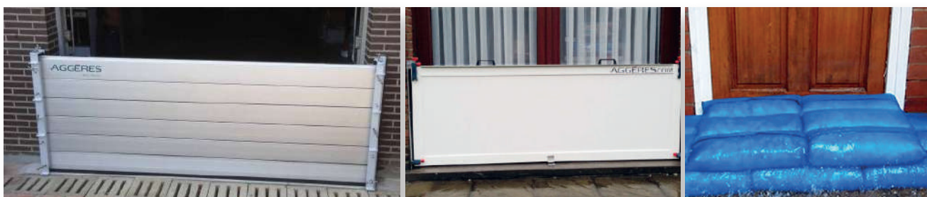
Figura 49. Medidas de protección anti-inundación temporales para puertas. Fuentes: izq. y centro: Aggères; dcha.: Digebis.
