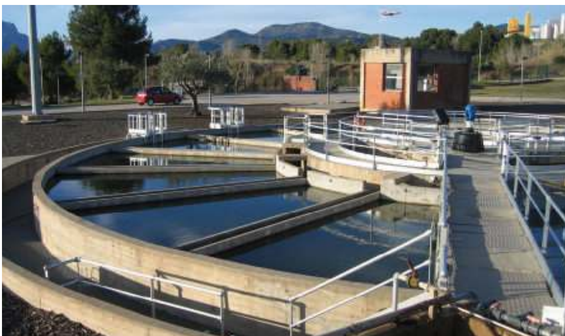
Figura 10. Planta de potabilización de Abrera. Aguas Ter Llobregat. Barcelona
