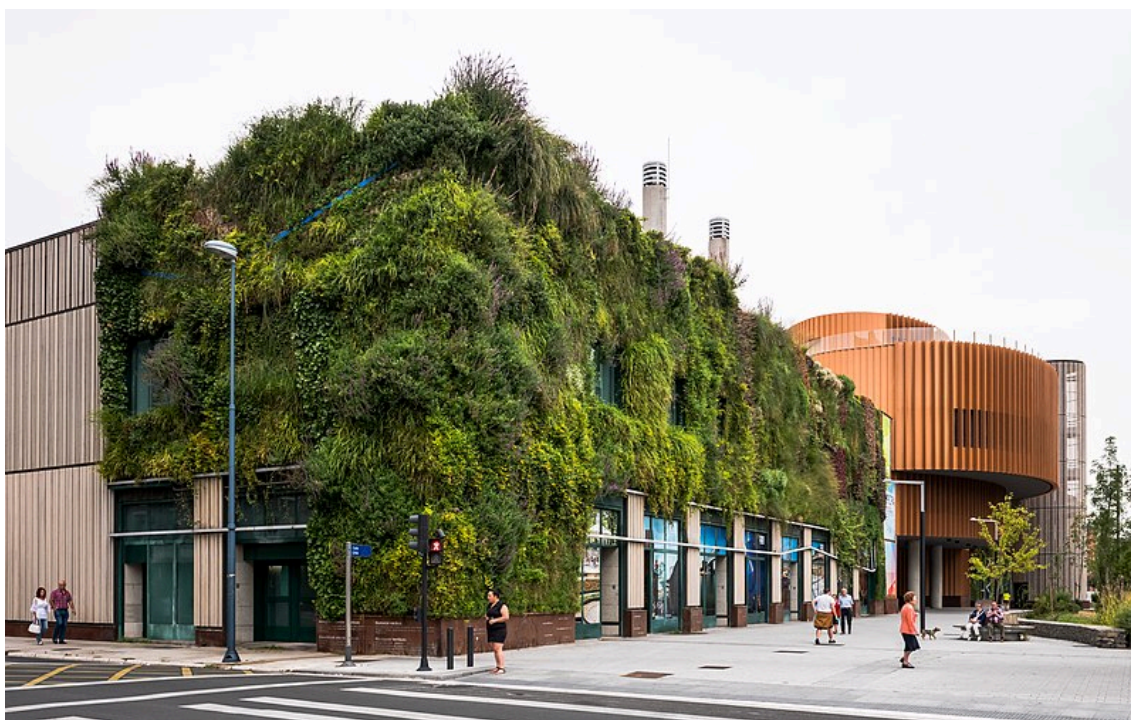
Figura 47. Ejemplo de infraestructura verde en la fachada del Palacio de Congresos Europa, en la ciudad de Vitoria. Fuente: Basotxerri .
