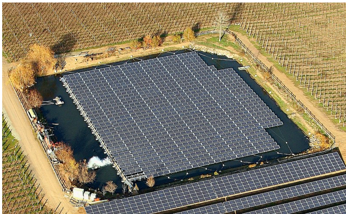
Figura 16. Paneles solares flotantes en un viñedo de California (EEUU). Fuente: SPG Solar .
