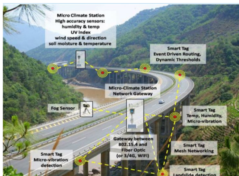
Figura 59. Ejemplo de una red de etiquetas eficientes, estaciones de microclima y componentes de la infraestructura de carretera conectados. Fuente: Proyecto PANOPTIS
