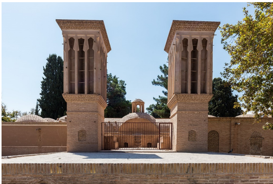
Figura 44. Bâdgirs (captadores de viento de viento). Fuente: Kheirkhah, P. y Nasrollahi N.
