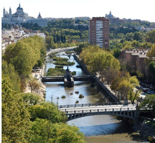
Figura 24. Renaturalización del cauce del río Manzanares a su paso por Madrid
